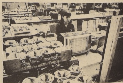
Fabricación de "Yugos" con cobre, pieza vital de TV (Coesa).
