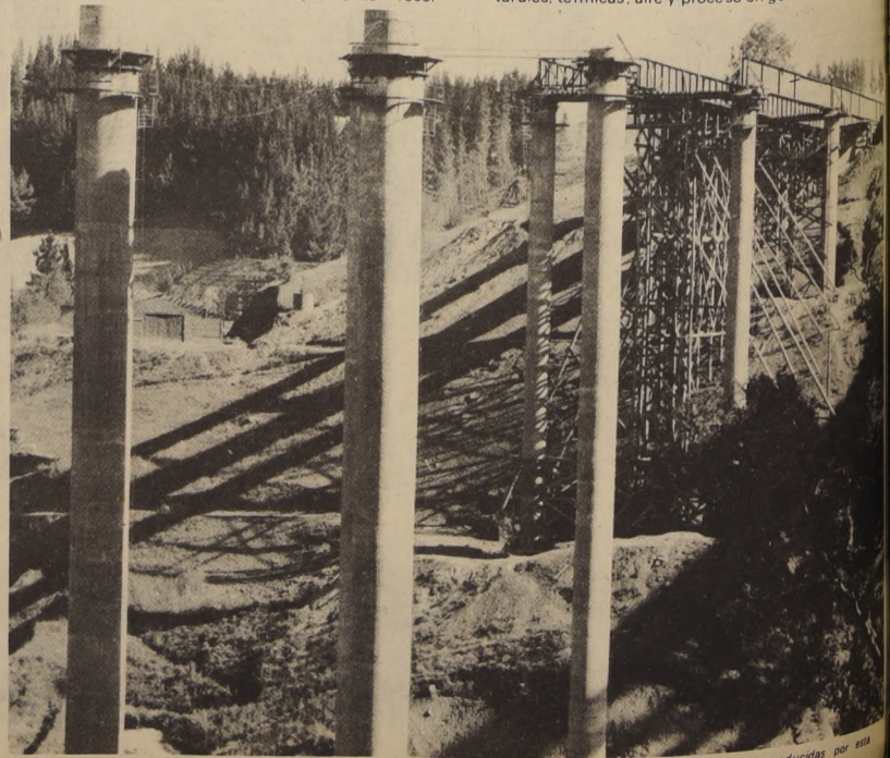
Las vigas metálicas de esta imponente obra de ingeniería, el puente carretero sobre el río Malleco, salieron de los talleres de la Planta de FERROCRET, en la misma forma que otras obras también contaron con estructuras producidas por esta empresa.
