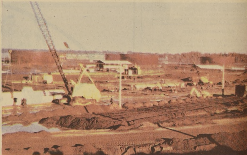
Estanques de almacenamiento de 34.500 m3
