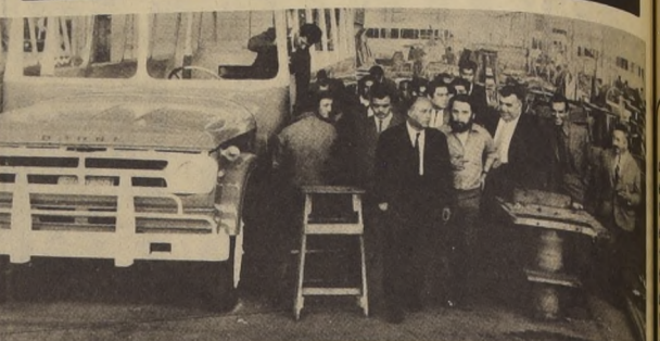
UNA VISITA A LA INDUSTRIA carrocería Franklin, ahora en manos de los trabajadores, hizo ayer el Ministro de Obras Públicas y Transportes, Pascual Barraza. El motivo fue la instalación de carrocerías para 26 chasis de la Cooperativa de Choferes "Coopcoipán". Le acompañó en esta visita, el Subsecretario de Transportes, Hernán Morales. Los nuevos microbuses viajarán entre la capital y el sector de Casas Viejas, de Puente Alto, pasando por Santa Rosa por el nuevo camino Gabriela recientemente inaugurado por el Ministro Barraza y autoridades de Vialidad.
