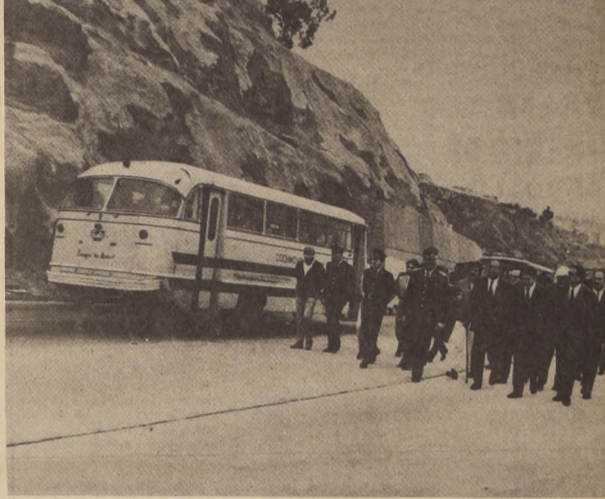
EL PRIMER TRAMO de la Vía Elevada que unirá Valparaíso con Viña del Mar, fue inaugurado por el Ministro de Obras Públicas, Pascual Barraza. Se trata de la Curva de Los Mayos, con una longitud de 437 metros y un ancho de 14.
