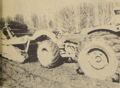
Las maquinarias de la Dirección de Obras Públicas están presentes en todos los caminos de Chile.
