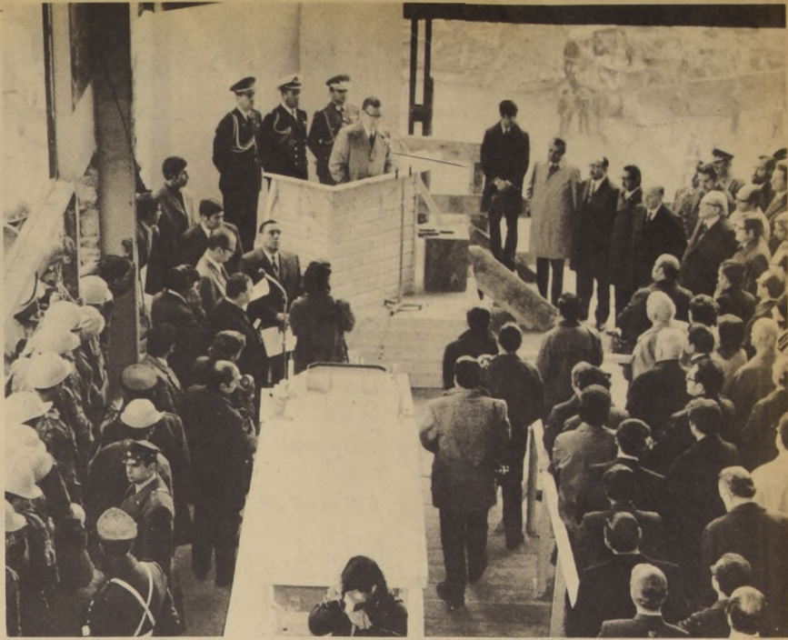
El edificio para sede de III UNCIAD, un desafío a la capacidad y al esfuerzo del trabajador chileno. Las obras para esta gigantesca construcción que debe estar terminada en marzo venidero fueron inauguradas por el Presidente de la República, Compañero Salvador Allende.
