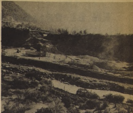
La Empresa de agua Potable de Santiago, a través de su Departamento de Construcción Directa, está ejecutando el Nuevo Conducto Independiente en pleno Cajón del Río Maipo. La obra, de gran envergadura, permitirá asegurar definitivamente el abastecimiento de agua a la población del Gran Santiago y comunas vecinas. La obra se construye con el esfuerzo mancomunado de 360 trabajadores, entre profesionales, técnicos y obreros.
