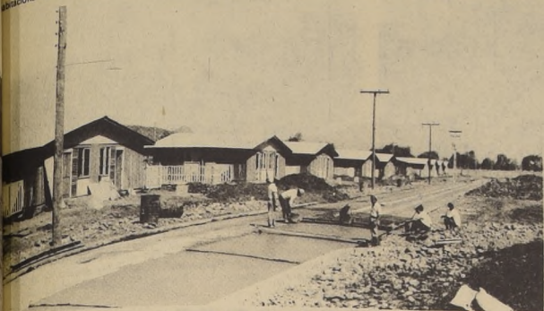
Población Cortijo Norte construida recientemente por la Corvi en la Comuna de Quilicura, 914 viviendas industrializadas.
