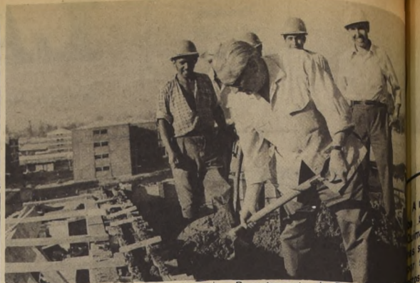
En un acto con la presencia del Ministro de Vivienda, Julio Benítez, fueron inaugurados los talleres del sector en construcción de la población Jaime Eyzaguirre, en la comuna de Ñuñoa. Las obras son construidas por el Departamento de Ejecución Directa de la CORVI, registrándose resultados positivos. Comprenden más de 40 departamentos, que favorecen familias que desde años están luchando por obtener una vivienda.
