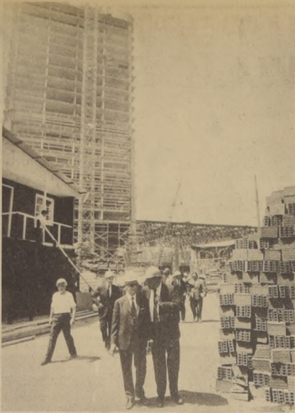
EL SECRETARIO GENERAL de la UNCTAD, Manuel Pérez Guerrero, acompañado del Secretario General de la Comisión Chilena Danilo Poklepovic visitan las obras en construcción de la sede de UNCTAD III
