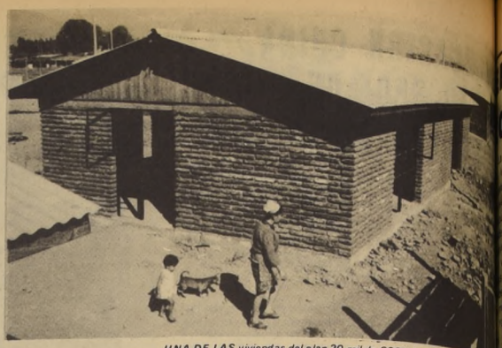
UNA DE LAS viviendas del plan 20 mil de CORHA. B) en la etapa de la obra gruesa.
