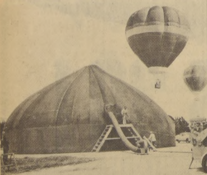
El globo de la fotografía, sobre la tierra, fabricado en Inglaterra, puede almacenar hasta 1.000 toneladas de grano. Hechos con caucho Butyl, a prueba de putrefacción, importan alrededor de tres mil libras esterlinas cada uno y los vende "Cherwell Valley Silos", de Bambury, Oxfordshire, Inglaterra (Foto Jackson, Gloucester).
