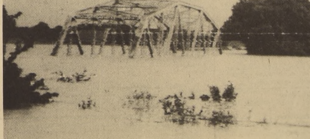
LAS AGUAS del río San Diego cubren la carretera central en un tramo de la vía que comunica la provincia de La Habana y Pinar del Río. Intensas lluvias, que han caído en la parte occidental de Cuba, motivadas por el ciclón "Laura", han provocado enormes daños como se puede apreciar en la foto. (Radiofoto Prens Latina).
