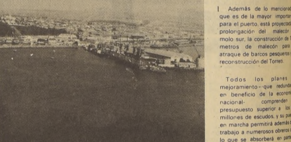
El puerto de San Antonio resultó seriamente dañado a consecuencia del terremoto del 8 de julio. Durante el año fue reparado y para el próximo se contempla numerosas obras que facilitan aún más las faenas de carga y descarga.
