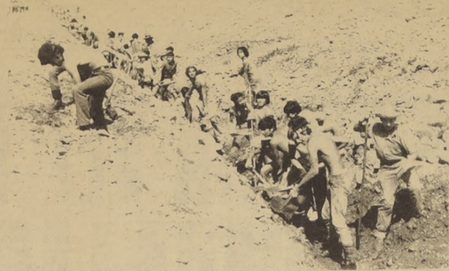
ES ÉL EL EJERCITO de jóvenes trabajadores voluntarios que está cavando en Cabildo, provincia de Aconcagua, bajo el ardiente sol, el gigantesco dren de 100 kms. de largo que dará vida y verdor a la zona, al hacer aflorar el agua subterránea. Dentro de poco, serán 3 mil los jóvenes que estarán trabajando en la histórica obra.
