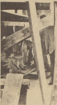
EL PRESIDENTE ALLENDE recorre las instalaciones en construcción de la Enoteca en el San Cristóbal.
