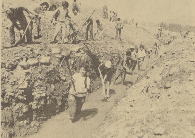
En plena faena los estudiantes que desde diversas provincias llegaron a Cabildo para construir un dren subterráneo que riegue los terrenos de la zona. Esta juventud coopera así con la responsabilidad de construir un Chile Nuevo.
