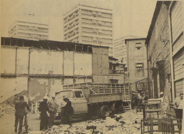
Una muestra de los contrastes arquitectónicos que a diario encontramos en la ciudad de Santiago.
