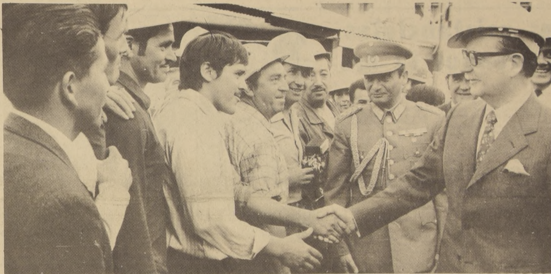
Una sorpresiva visita efectuó el Presidente de la República, Salvador Allende, al edificio en construcción de la UNCTAD. El Primer Mandatario fue recibido afectuosamente por los trabajadores a quienes felicitó por la labor desarrollada hasta la fecha.
