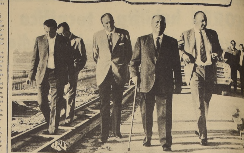
El Ministro de Obras Publicas, Pascual Barraza, recorre el nuevo puente sobre el rio Bio Bio, en la provincia de Concepción. El martes el Secretario de Estado estuvo en los centros mineros y se reunió con los alcaldes de los centros del carbón.
