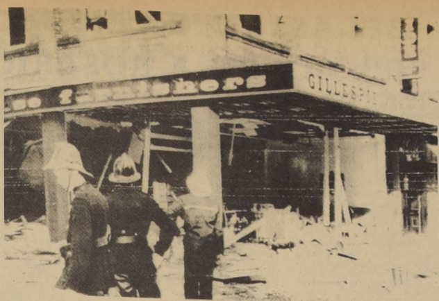
BELFAST Irlanda del Norte. Bomberos observan los destrozos provocados por bombas en un local comercial...
