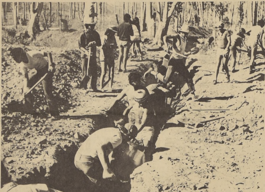
CUANDO LOS TRABAJOS terminen, Cabildo tendrá 500 hectáreas más de riego. Las faenas en el DREN producirán 340 litros de agua por segundo.
