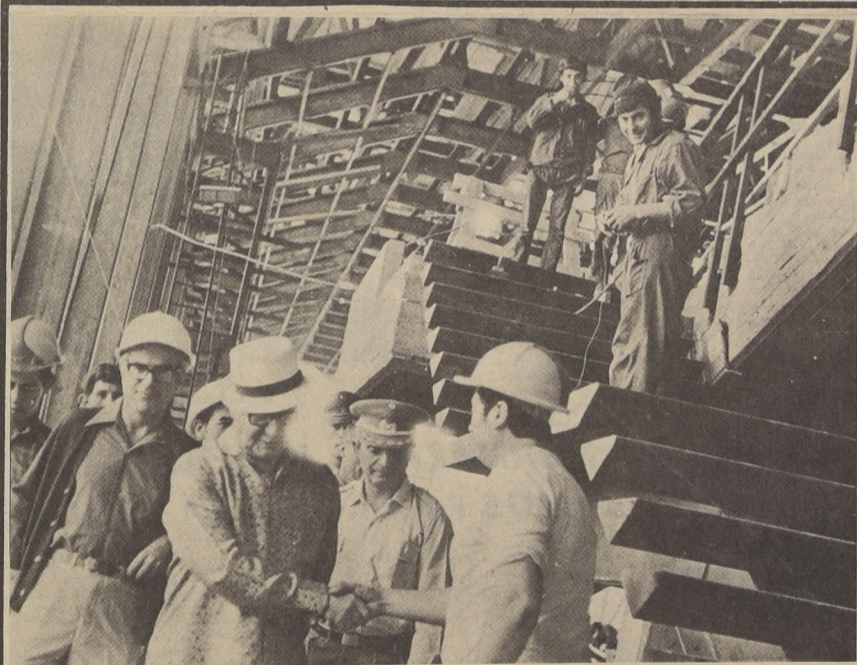
El Presidente Allende, en la mañana de ayer, realizó otra de sus acostumbradas visitas sorpresivas a las obras que constituyen el moderno edificio en donde se desarrollarán las sesiones de la UNCTAD III. En la foto, el Compañero Presidente inspecciona las labores que deben dar cima a la monumental estructura, a fines del próximo mes. Tras el diálogo con los propios trabajadores, el Presidente se retiró conforme con el avance que se observa tras cada visita suya.
