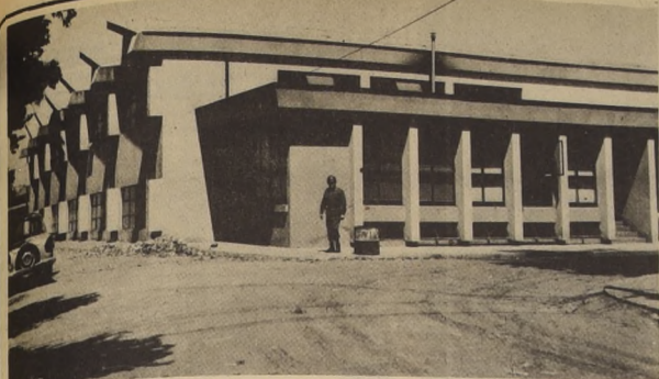
NUEVAS INSTALACIONES del Pabellón de Fusiles, de FAMA E.
