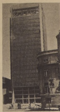
EL EDIFICIO donde se desarrollará la Conferencia de la UNCTAD III fue construido especialmente con este propósito. Un elemento de esta construcción, la Torre, ya está terminada en su obra gruesa. Tiene 23 pisos.
