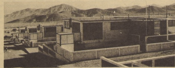
No sólo en Santiago se construye. Un ejemplo es este grupo habitacional de Calama.
