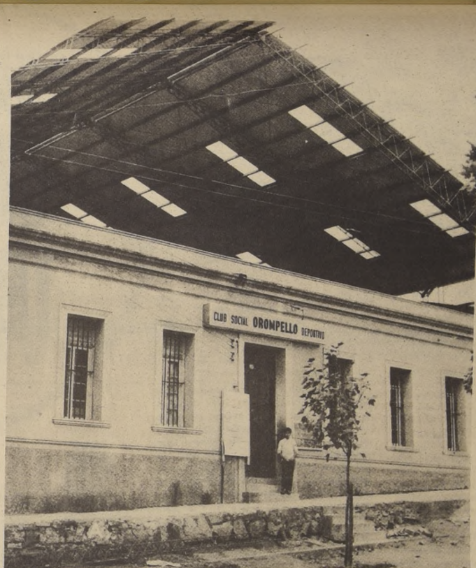
EL FRONTIS del Club Social y Deportivo Orompello. Atrás se observa la estructura del gimnasio que “nace”.
