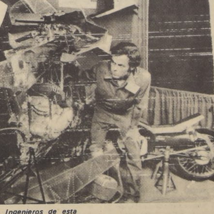
SAN FRANCISCO.- Ingenieros de esta localidad exhibieron una revolucionaria creación de motocicleta, en cuya construcción el acero fue reemplazado por durior aluminio. El motor empleado fue un Kawasaki, con 500 centímetros cúbicos. En la foto, uno de los inventores contempla su creación (Radiofoto UPI).
