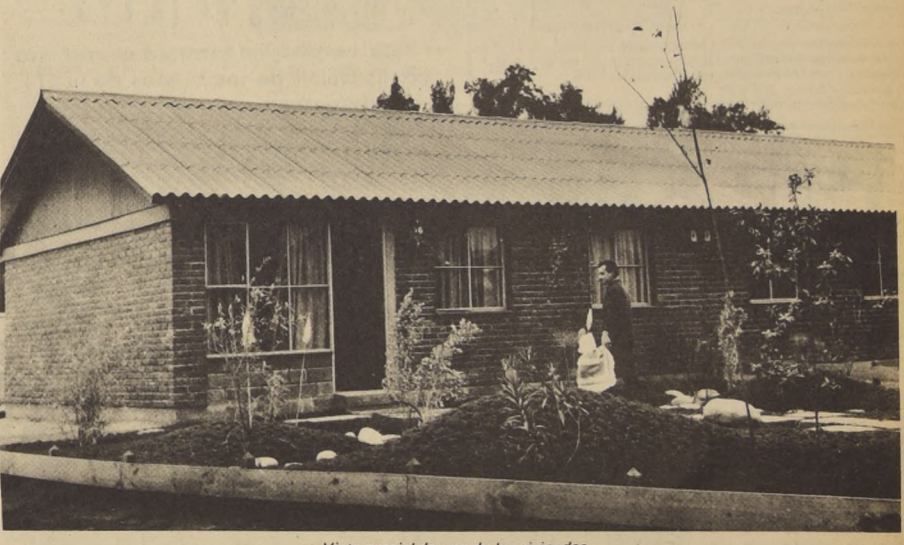
Vista parcial de una de las viviendas
