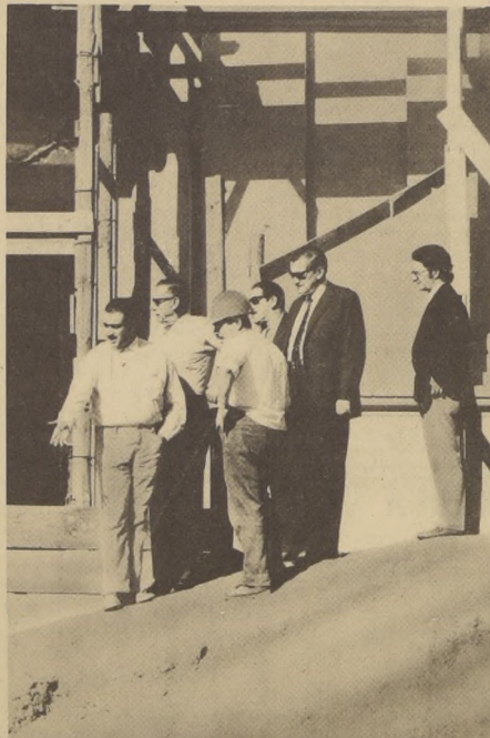
El alcalde de Valparaíso, Sergio Vuskovic y el arquitecto municipal, Reinado Meneses, visitaron la Iglesia La Matriz de Valparaíso, incluida en la Ley de Reconstrucción para nuestra ciudad. Pueden verse los andamios colocados para sostener la estructura que estaba siendo restaurada por la Municipalidad al ocurrir el sismo de julio del año pasado, e iniciativa del Comité de Defensa de la ciudad, que preside el alcalde.
