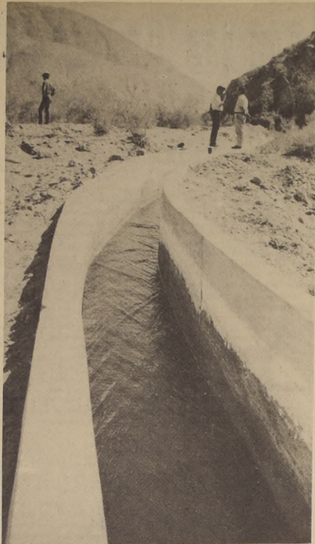
OCHO KILOMETROS DEL Canal Volado, en el interior del Valle de San Félix, fueron revestidos por trabajadores de la Dirección de Riego, de la Dirección General de Aguas, del Departamento de Recursos Hidráulicos de CORFO y de la Oficina de Saneamiento Rural del Servicio Nacional de Salud, dirigidos por la Comisión Nacional de Sequía. Esta vía de agua unifica otros cinco canales que son absolutamente necesarios para los agricultores y campesinos de esa región de la provincia de Atacama, según informó el Secretario Ejecutivo de la Comisión Nacional, coronel en retiro Raúl González. EN LA FOTO: una parte de las obras en el canal ubicado en el interior del Valle de San Félix.
