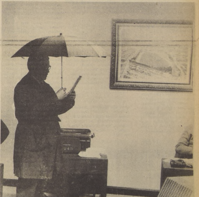
CUANDO LLUEVE... TODOS SE MOJAN en la tribuna de prensa del Hipódromo Chile, menos, lógicamente, los que usan paraguas... La tribuna está mal pintada, muy deteriorada y su techo no se ha impermeabilizado. En una de las últimas lluvias hubo una profusa gotera por sobre una lámpara de tubos fluorescentes. Sería bueno que las autoridades le dieran su manito a los "niños de la prensa".
