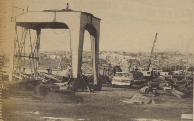
En forma activa los trabajadores portuarios se han abocado al despeje del sector de Avenida Costanera, donde se encontraba depositado el material de escombros proveniente del desarme del Espigón para entregar a la comunidad de Valparaíso un nuevo Paseo Público junto al mar.
