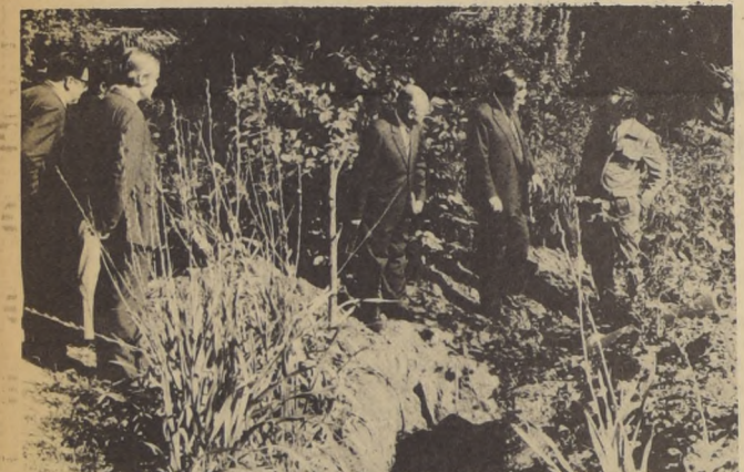
YA SE ESTAN INSIALANDO las primeras estructuras metálicas para la Primera Feria Internacional de Valparaíso que se inaugura en noviembre próximo y que tendrá carácter permanente. Los terrenos ubicados en Villa Lenin, ex Quinta Alfaro fueron visitados por el alcalde Pedro Vuscovic Rojo y Jefe de Servicio.
