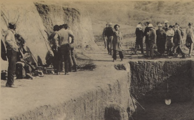
LAS AUTORIDADES DE RIEGO, y la diputada Laura Allende, visitan las obras del mayor proyecto de regadío del país: el canal Santiago-Peñuelas.
