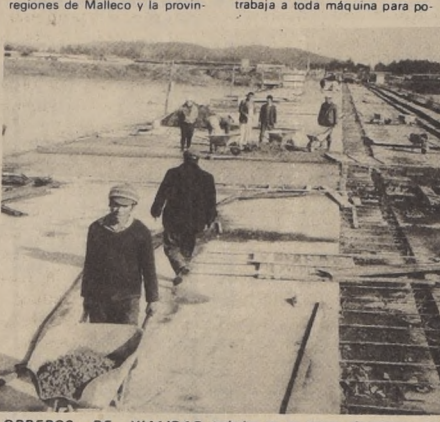
OBREROS DE VIALIDAD trabajan en un tramo gigantesco del Bio Bio, lo que unirá dos frentes de trabajo.
