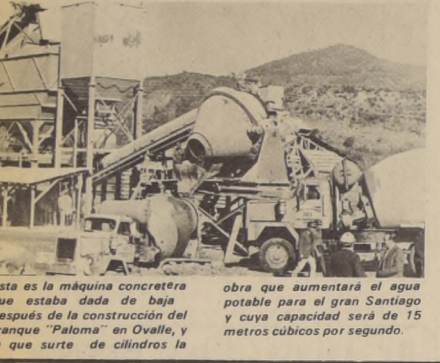
Esta es la máquina concretéra que estaba dada de baja después de la construcción del trazo "Paloma" en Ovalle, y la que surte de cilindros la obra que aumentará el agua potable para el gran Santiago y cuya capacidad será de 15 metros cúbicos por segundo.
