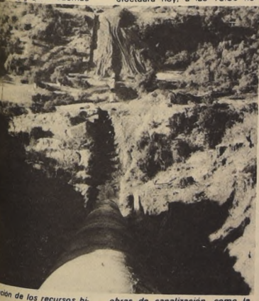
obras de canalización, como la que puede apreciarse en la ilustración.
