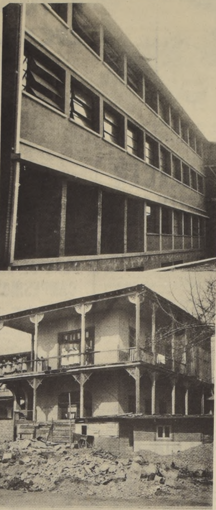
El Hospital Psiquiátrico de Santiago cumplió 120 años de vida. Un nuevo edificio ha surgido dejando de lado la vieja casaca de los primeros tiempos.
