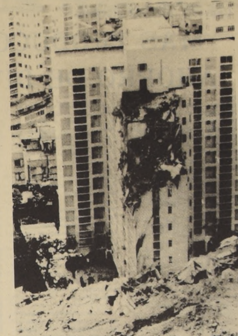
HONG KONG.— Vista de los destrozos en un edificio de departamentos de esta ciudad, ante las avalanchas como consecuencia de la acción devastadora de torrenciales lluvias, consideradas las más graves en los 83 años de vida de esta colonia inglesa. Por efecto de avalanchas han perecido 57 personas y unas 40 resultaron heridas. (Radiofoto UPI)
