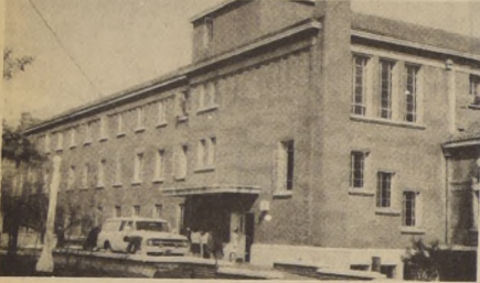
EN EL HOSPITAL de la Fuerza Aérea de Chile, ubicado en Avenida Las Condes, se efectuará un curso de cirugía para graduados.
