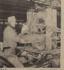
Máquina para armar vigas doble T.
