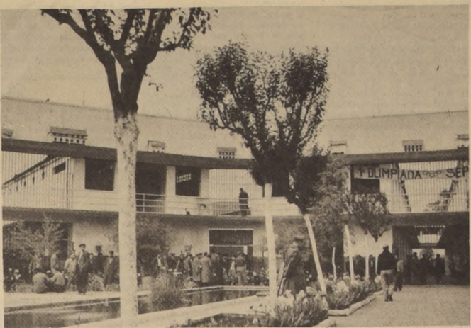
Viejos edificios carcelarios serán reemplazados por nuevas estructuras, con las mejores condiciones sociales y humanas para los penados.
