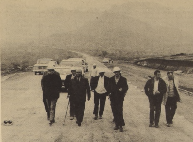
El Ministro Pascual Barraza visitó el camino de acceso al túnel de Chacabuco que se inaugura el próximo martes.
