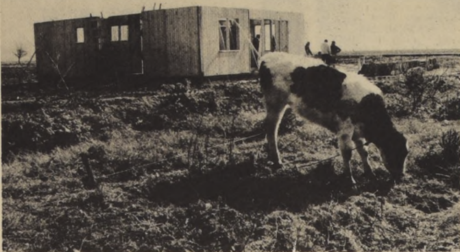
CAMPESINOS DE "LOS RULOS" construyen sus propias casas, para mejorar sus condiciones de vivienda. La mayoría de ellas estaban en pésimas condiciones, cuando el predio fue expropiado por la Corporación de la Reforma Agraria, debido al terremoto que afectó la zona el año pasado. Hasta el momento se está utilizando material prefabricado para completar el programa que incluye 18 casas para los trabajadores.
