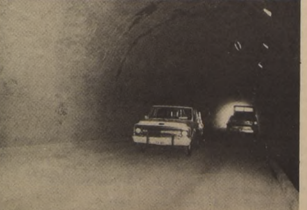
Un aspecto del viaducto subterráneo Chacabuco.
