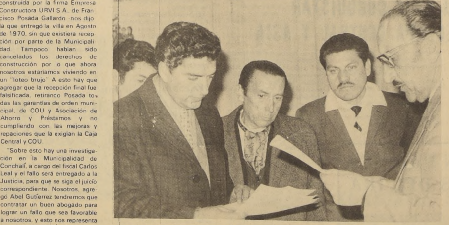
DIRIGENTES de los pobladores de la Villa Zapadores dan cuenta de las irregularidades que hay en la parte legal como en la construcción de las viviendas en la Intendencia de Santiago. Las casas se están derrumbando debido a la mala construcción y la pésima calidad de los materiales utilizados. Los pobladores piden que se tomen medidas contra el constructor, Francisco Posada Gallardo.
