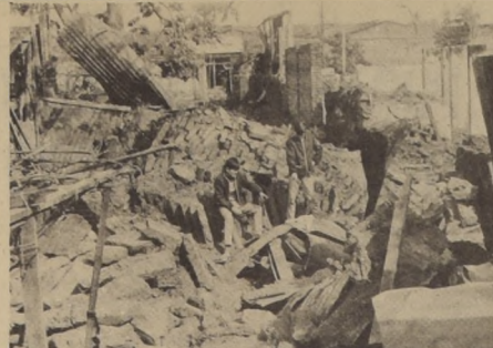
Los niños muestran el sitio exacto donde pereció aplastado bajo la inmensa muralla de adobes el comerciante que se aprestaba a encender fuego en su casa, ayer a las nueve de la mañana.
