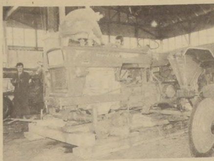
Planta Las Rejas está entregando 30 tractores diarios para la modernización de la agricultura.
