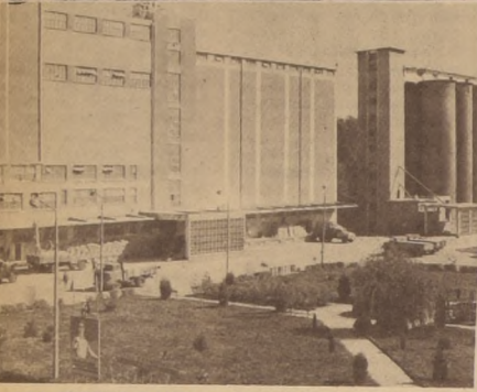
UNA MODERNA PLANTA para mezclas forrajeras, muestra de lo que ha sido el crecimiento de Bulgaria
