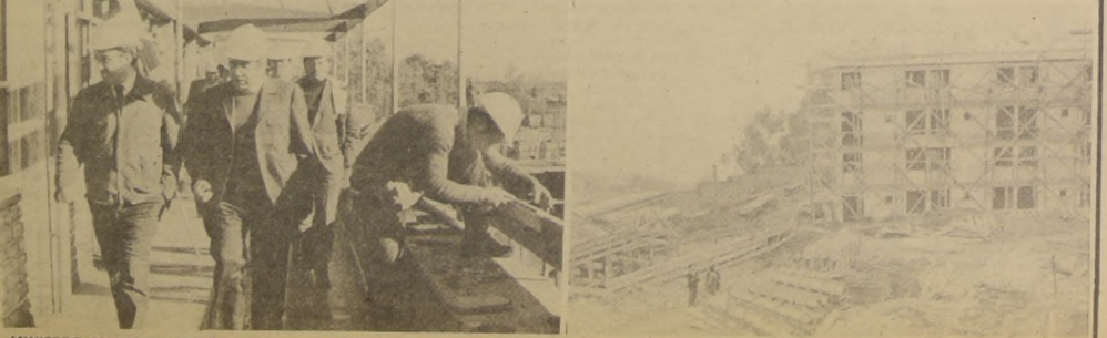
MINISTRO MATTE VALDES: gran limitante de la solución del problema habitacional es la falta de capacidad de producción de las industrias que fabrican los insumos necesarios. CHILE construye para su pueblo. Conjunto "Baldomero Lillo" en Lota Alto.
