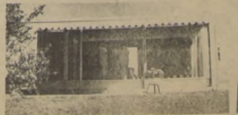
"CABINOVA" de 28 mt. 2 construída con plástico reforzado
