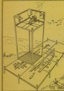
TORRE FOTOGRAFICA. De 4,50 metros de altura, descansa sobre una armazón horizontal. Para obtener las fotografías estereoscópicas se desliza el aparato fotográfico por las barras horizontales de la parte superior o se desliza toda la armazón de un punto a otro.
