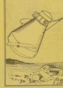
CABINA DE OBSERVACION. Artefacto de acero remolcado por una barcaza. El piloto puede mirar a todos lados gracias a una ventanilla circular de plexiglas y controlar el rumbo de la cabina manejando las aletas laterales. Se ha utilizado en profundidades de 100 metros y resulta especialmente útil para la exploración en aguas claras.
