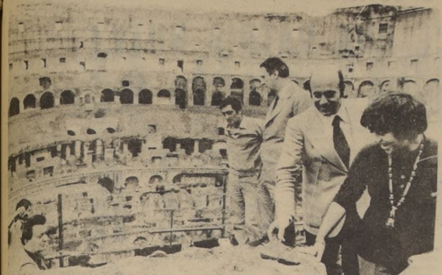
ROMA. EL SUPERINTENDENTE de la ciudad Eterna, arqueólogo Alveno Pastorelli, acompañado de Barbato Graziana, observan, junto a otros miembros de la Comisión encargada de restaurar el Coliseo, las grietas que se han producido en esta antigua obra, que tiene 1892 años de existencia. Los turistas pueden ver sólo parte de esta gran obra, pues hay peligro de derrumbes. RADIOFOTO UPI.
