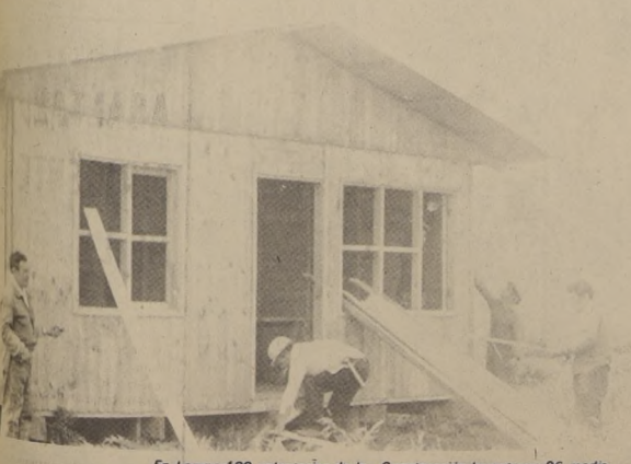
En Lampa: 100 voluntarios de la Construcción levantaron 96 mediguas.
