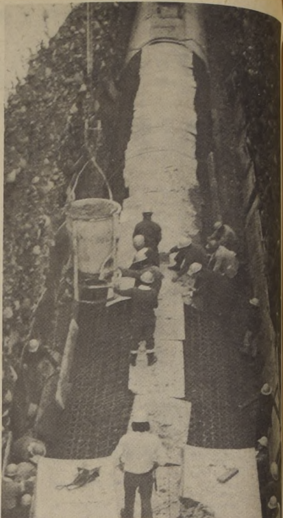
En el grabado, una cuadrilla de 25 trabajadores concreta un tramo del conducto de aducción que forma parte de la obra "Toma Independiente del Río Maipo". El conducto tendrá una longitud de 5.087,58 metros y 2,60 metros de diámetro.
