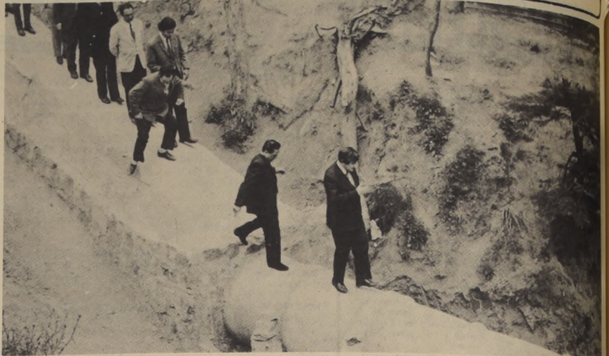
El Alcalde de Valparaíso, Sergio Vuskovic, en compañía de regidores y jefes de Servicios, visitó las obras de abovedamiento y relleno que se realizan en el cerro Mesilla de nuestro puerto, trabajos que han costado $ 800.000 a la Municipalidad portena y que se han realizado sin contratistas, solamente por Administración y con aportes municipales y de los pobladores.
